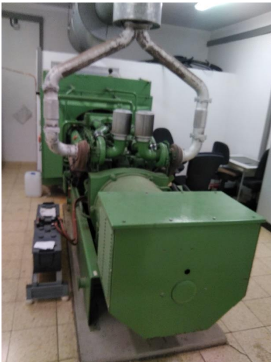
Abbildung 121: Notstromaggregat
