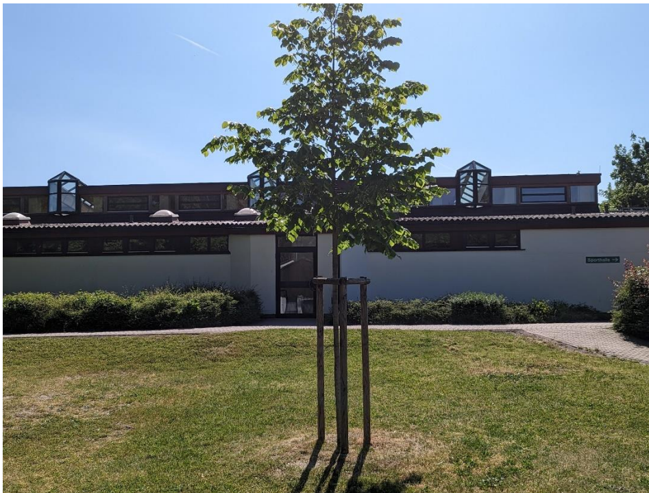
Abbildung 43: Ansicht West Eingang Umkleiden mit Sporthalle
