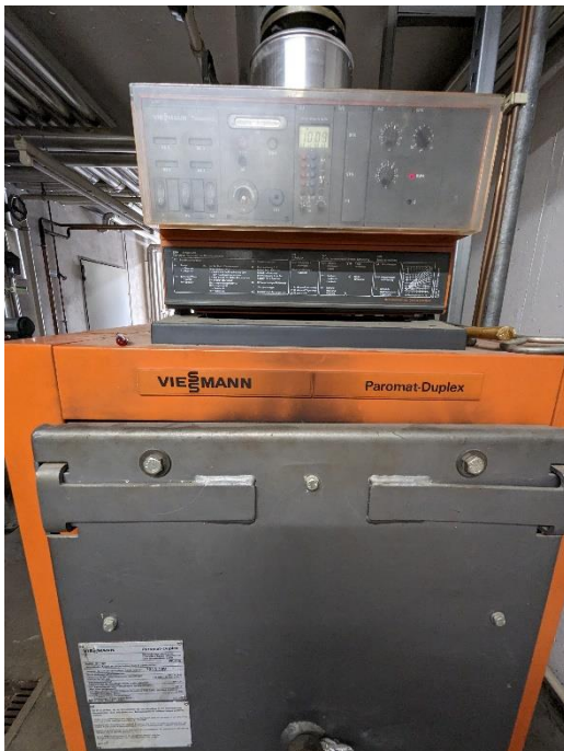
Abbildung 60: Heizkessel Sporthalle
