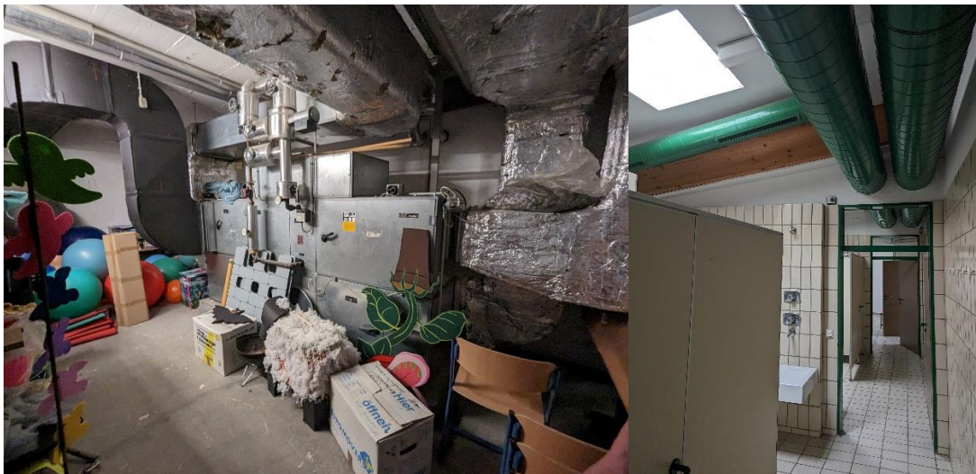
Abbildung 64: Lüftungsanlage Sanitärräume
