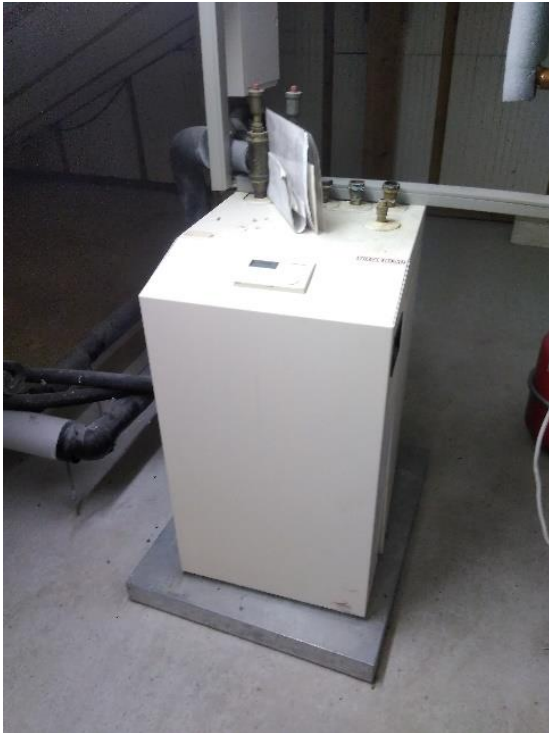
Abbildung 116: Wasser-Wasser-Wärmepumpe
