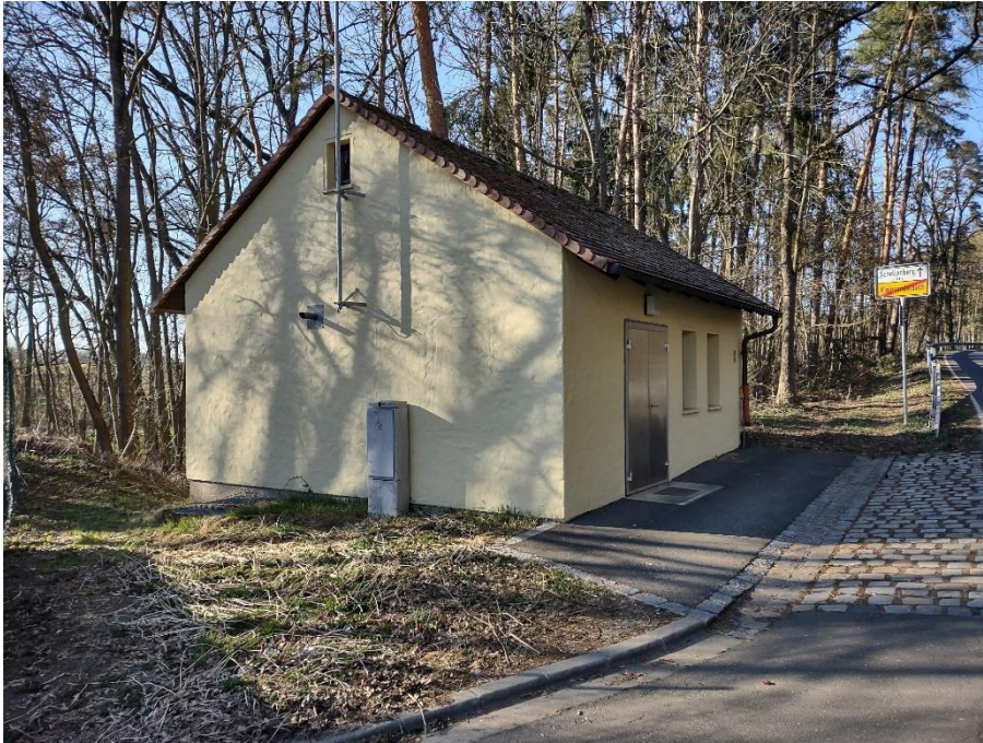
Abbildung 156: Gebäude Druckerhöhung Kleinsendelbach
