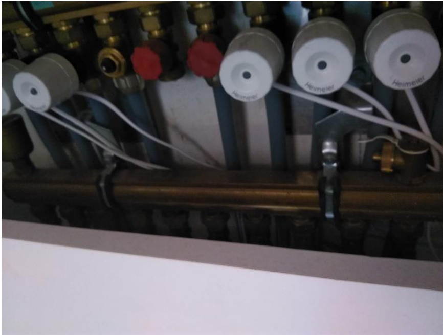
Abbildung 118: Regelung Fußbodenheizung
