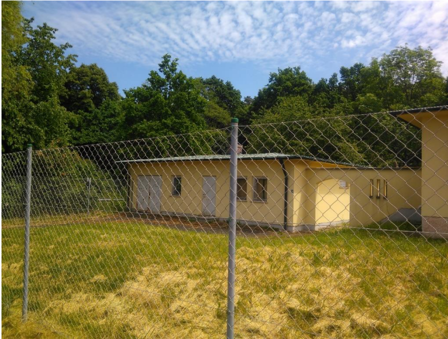
Abbildung 157: Brunnengebäude Tiefenbrunnen 1 „Altes Wasserwerk“
