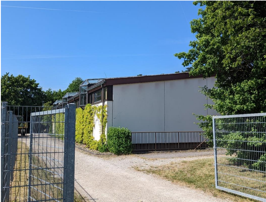
Abbildung 44: Ansicht Nord-Ost Sporthalle
