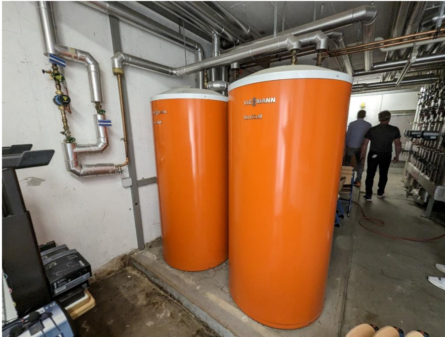
Abbildung 63: Warmwasserspeicher
