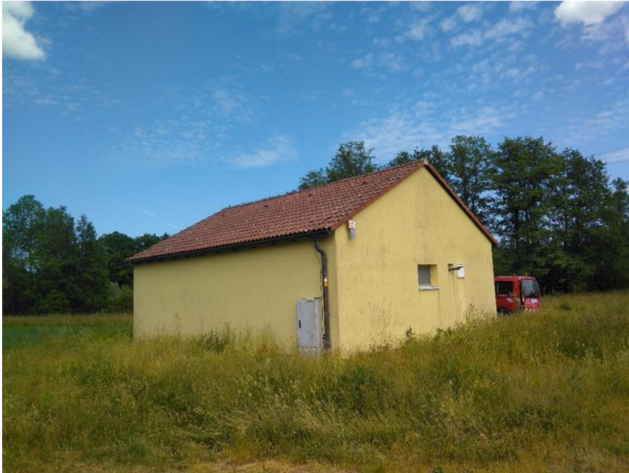
Abbildung 139: Gebäude Druckerhöhung Mausgesees
